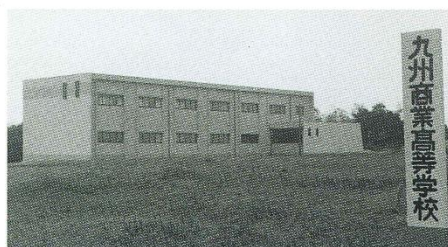
完成した新校舎 (昭和42年12月)
