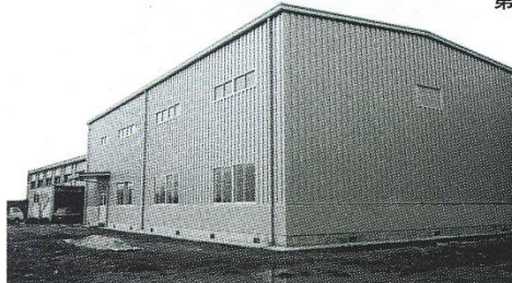
完成した武道館 (昭和52年3月)
